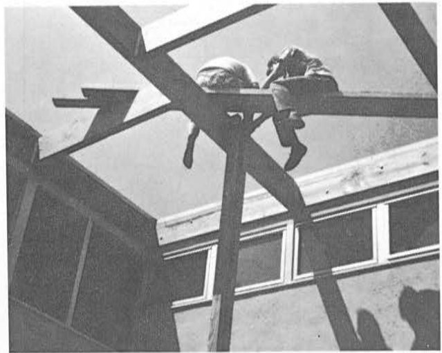
Eta Delta Brothers working on atrium
